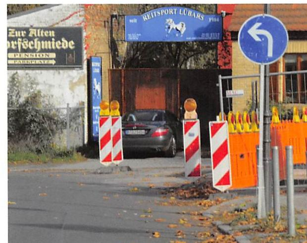
Bild 8: Baustellensicherung links-rechts
