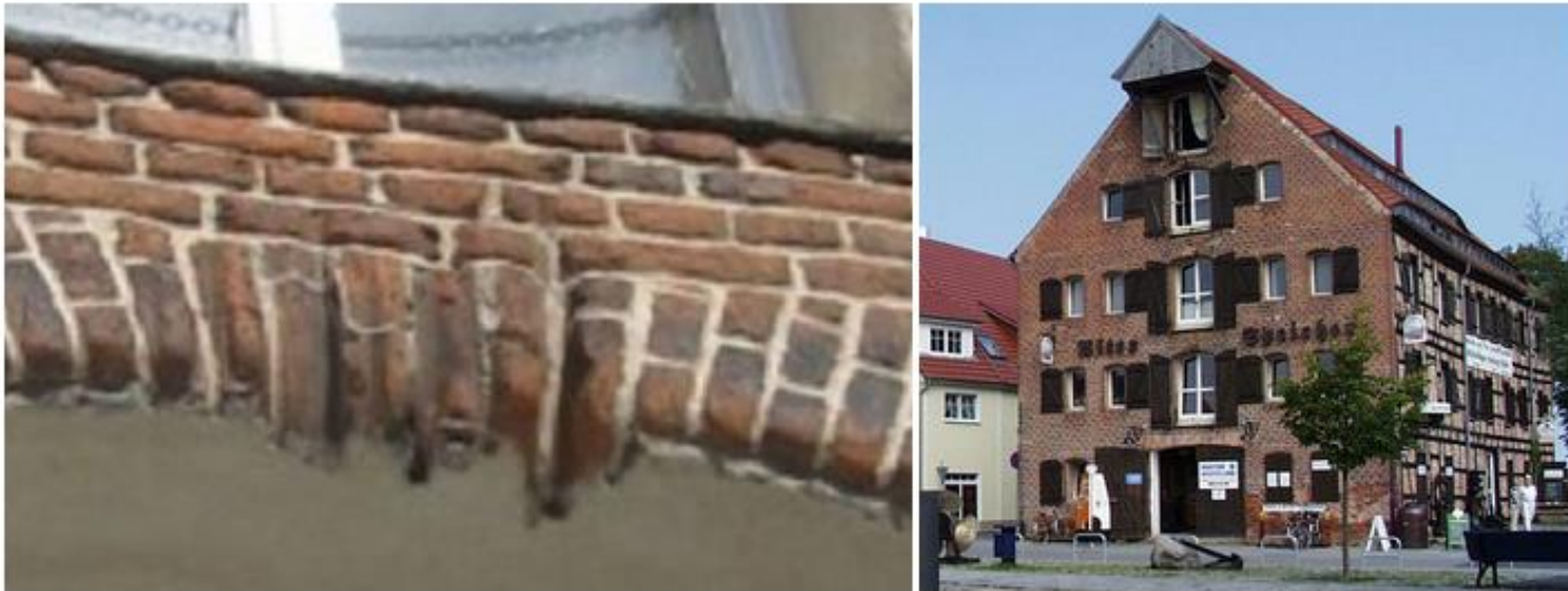
Bild 4 Alter Hafen in Wolgast, Ziegelspeicher um 1835 erbaut (Foto rechts: Wikipedia). Abnutzungsbeschädigungen an den Stürzen durch die Seile der Flaschenzüge, Zeitwert gegen 0 wegen Abnutzung ?
